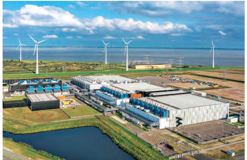
Das Google-Rechenzentrum in Eemshaven an der Nordsee.
